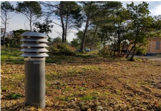
Le Puit Climatique est une **solution géothermique** de surface ayant pour objectif de réchauffer l'air neuf en hiver et de le rafraîchir en été. Ce système s'appuie sur des échanges thermiques entre la température de l'air capté à l'extérieur du bâtiment et celle du sol qui tend à devenir constante lorsqu'une profondeur suffisante est atteinte.
